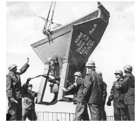
Укладення першого кубу бетону на будівництві головного корпусу (1967)
