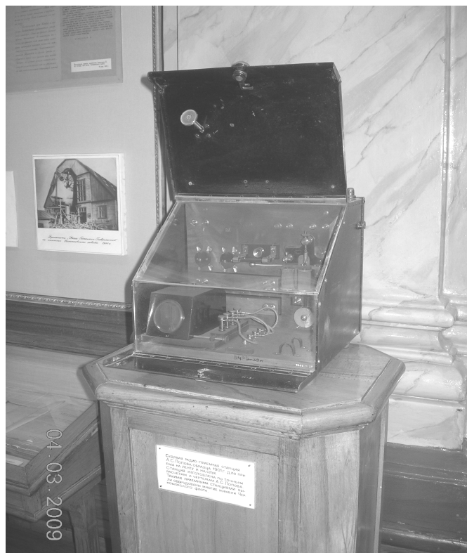
Рис. 9. Судовая радиоприемная станция А. С. Попова образца 1901 г. для приема на ленту и на слух. Такими станциями были оборудованы многие корабли Черноморского флота
